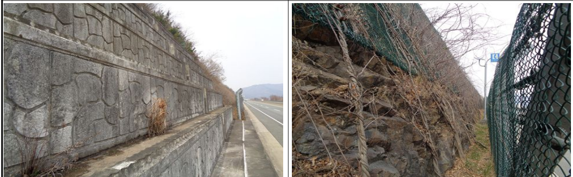
1단 계단식옹벽 전경
